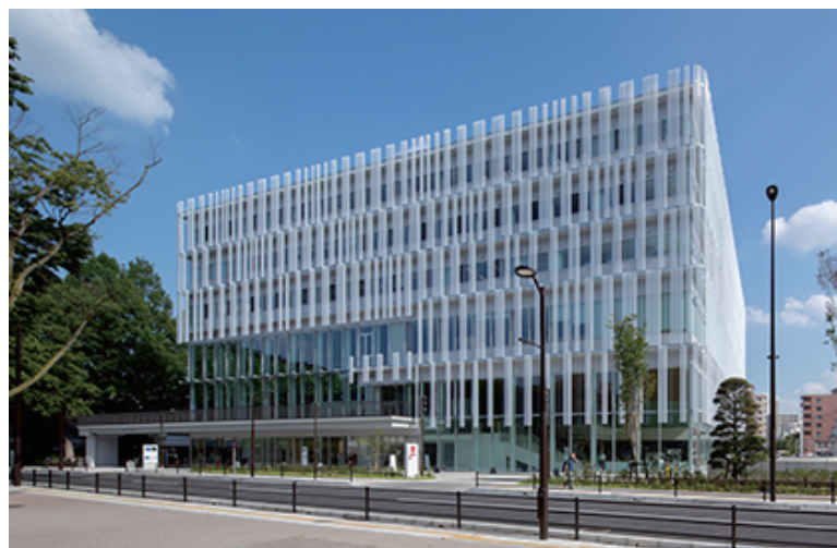
建物を外からみた写真
